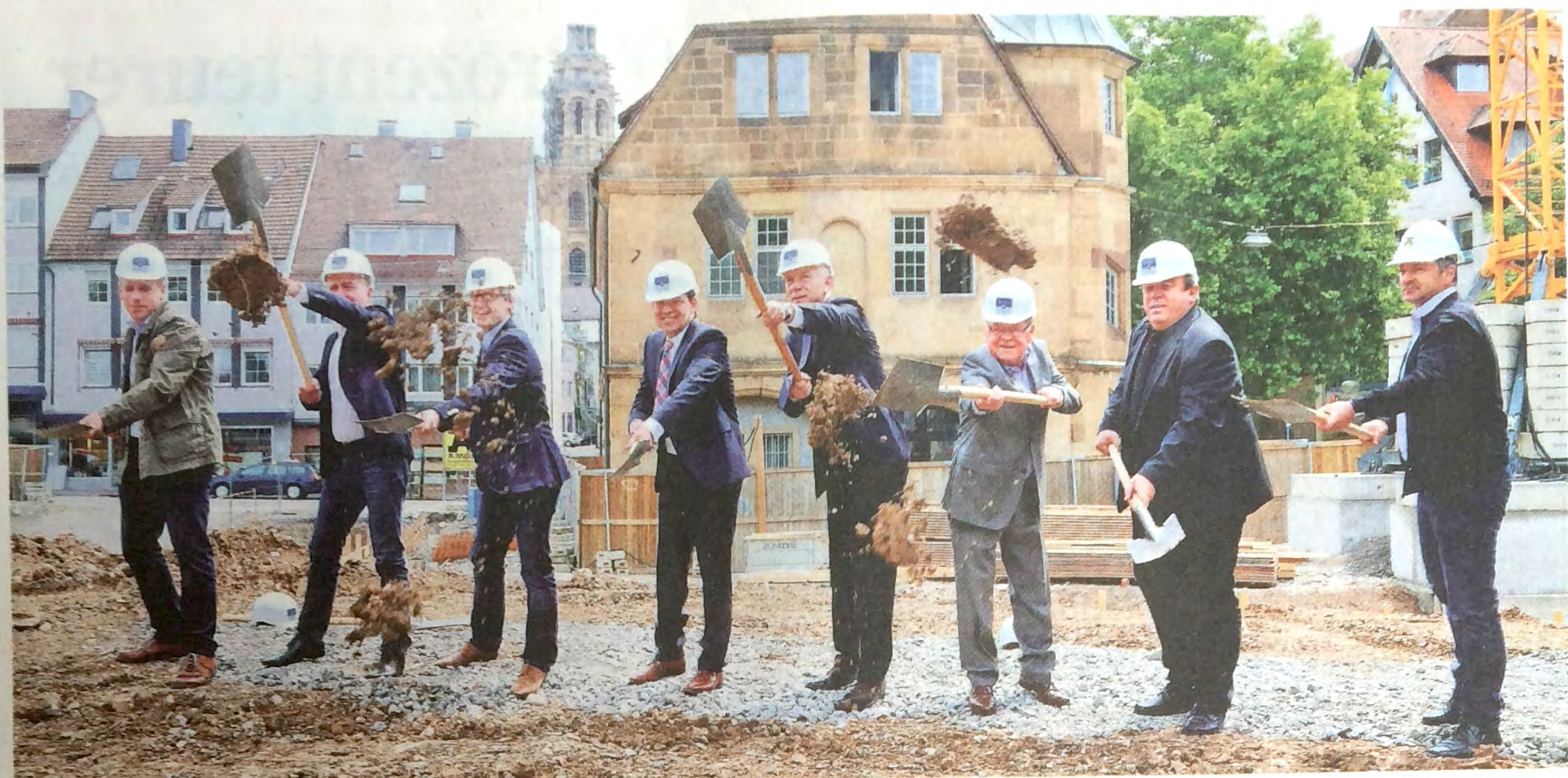
Bauleute und Investoren nehmen Harry Mergel bei seinem ersten Spatenstich als Oberbürgermeister auf dem C&A-Gelände in die Mitte.
