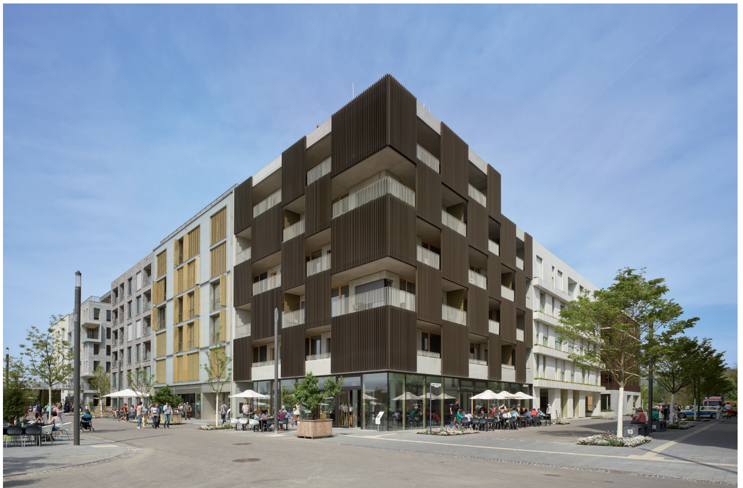
WOHNQUARTIER DER VIELFALT IM NECKARBOGEN HEILBRONN Baufeld I, Haus 3 Fotograf: Roland Halbe
