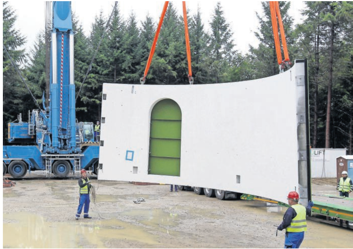
Gemächlich schwebt dieses Ringdrittel über die Baustelle. In den kommenden Tagen will Enercon die ersten Elemente montieren. Zuvor aber muss die Kellerplatte eingebaut werden. Dafür ist trockenes Wetter notwendig.
