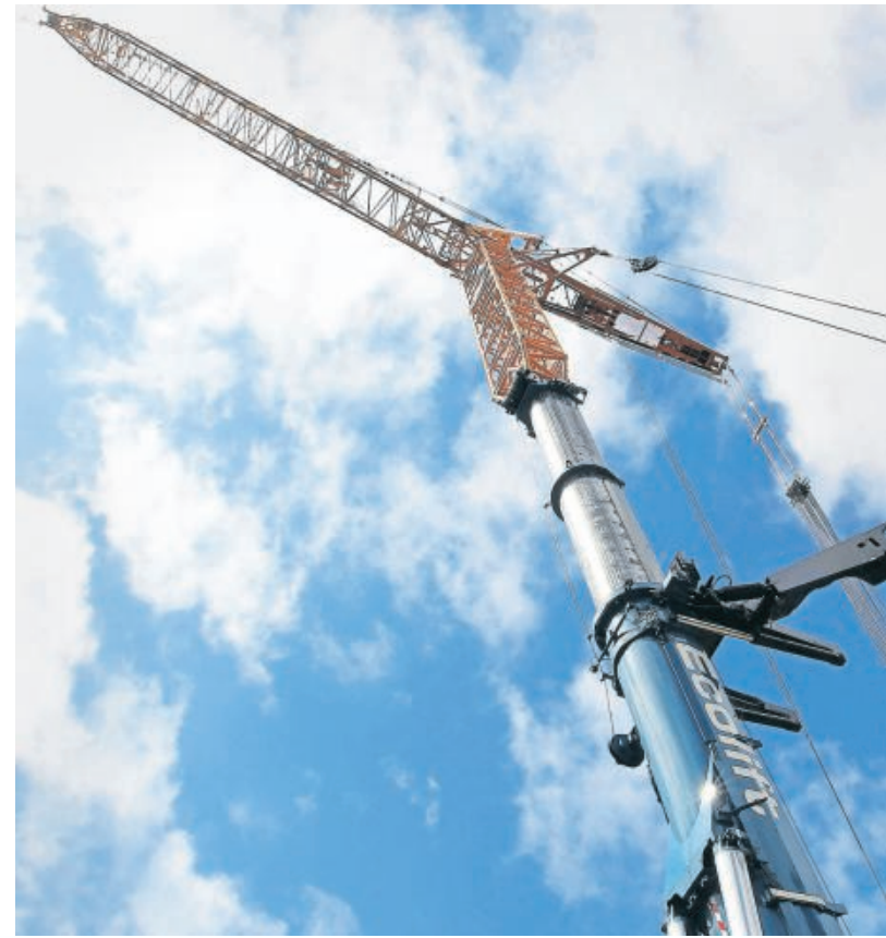
Ein mächtiger Teleskop-Kran, der maximal 750 Tonnen heben kann. Für die Montage von Gondel, Generator und Flügel ist er aber nicht leistungsfähig genug.
