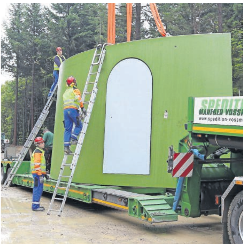
Arbeiter bereiten ein 30 Tonnen schweres Ringdrittel vor, damit es abgeladen und zwischengelagert werden kann.
