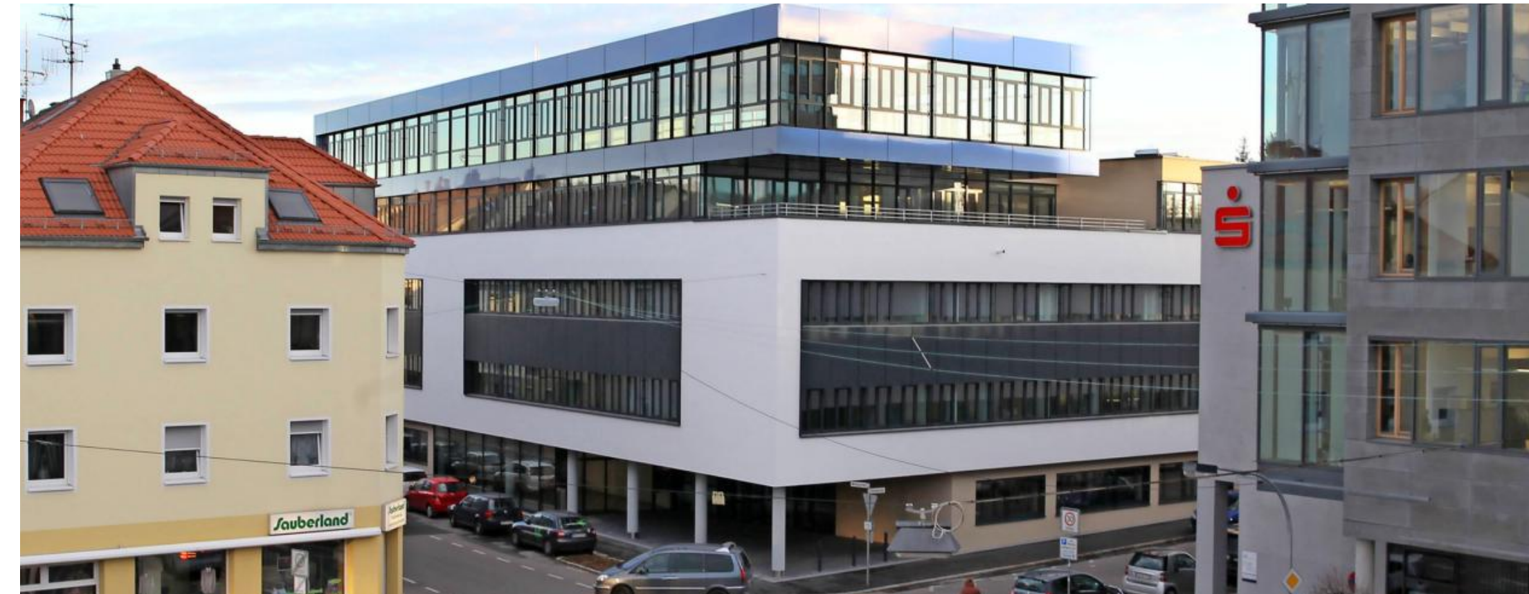
In eineinhalb Jahren Bauzeit entstand an der Ecke Wollhaus-/Uhlandstraße ein modernes, fünfstöckiges Gebäude. Blickfang ist das scheinbar frei schwebende vierte Obergeschoss.
