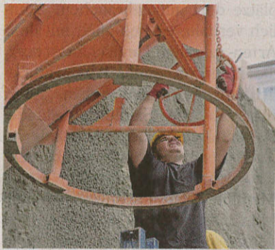
Ein Betonkübel mit etwa einem Kubikmeter Inhalt wird gerade geöffnet.
