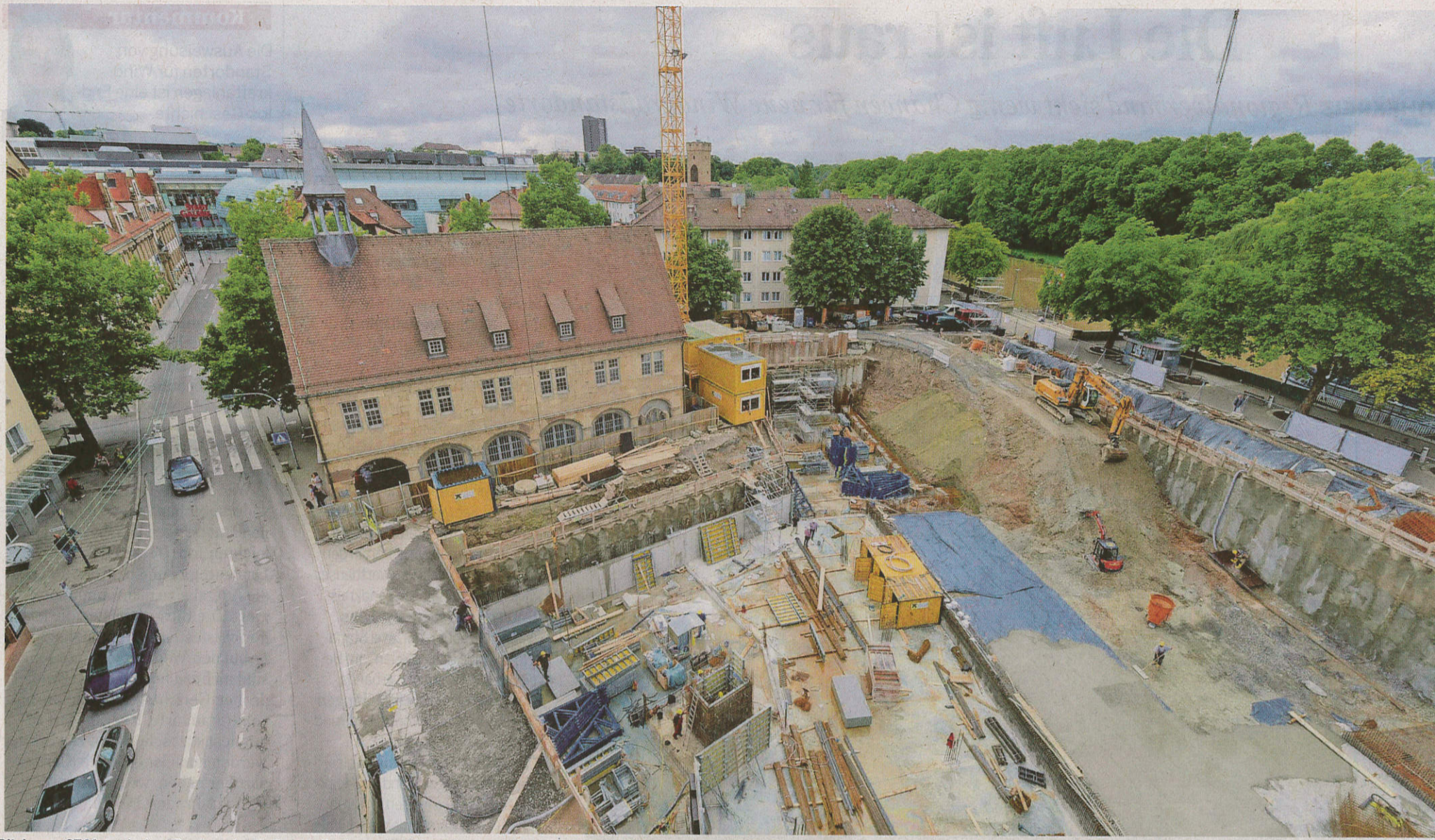
Blick vom 37 Meter hohen Baukran in die Baustelle des neuen Marrahauses. Hier entsteht die Tiefgarage mit 89 Stellplätzen. Direkt angrenzend das zierliche ehemalige Fleischhaus.
