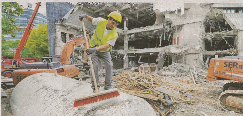
Ein Bauarbeiter der Firma SER reinigt den Druckbehälter der C&A-Sprinkleranlage. Dessen Weg führt wie der von Motoren oder Pumpen zu örtlichen Schrotthändlern.
